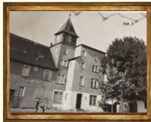
Abb. 3: flaches Dach und Glockentürmchen
